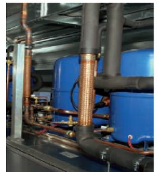
Integrierte Kälteanlage zur thermodynamischen Luftbehandlung
